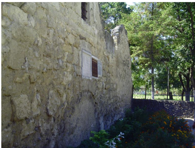
Horní polovina brány opevnění trhu Bilohirsk. (zdroj: autorská vlastní tvorba)
